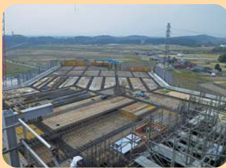
建設中の最上部(8・9階部分)
